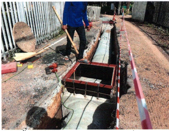
๓๒.โครงการวางท่อระบายน้ำ กลุ่มบ้านนางต้อย บุญนงษา หมู่ที่ ๑๐ (บ้านท่าคล้อเหนือ)
