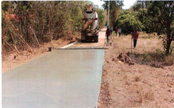
๒๗.โครงการปรับปรุงฝายน้ำล้น คอนกรีตเสริมเหล็ก(ชนิดรถยนต์ผ่านได้) หมู่ที่ ๕ (บ้านคำใหญ่)
