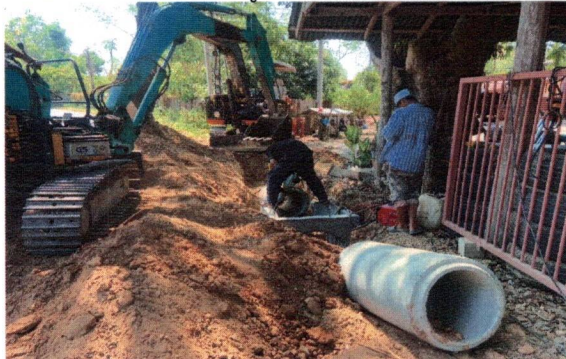
๓๕.โครงการวางท่อระบายน้ำ คสล.ชั้น ๓ หมู่ที่ ๒ (บ้านท่าสบก ซอยโนนอีแซว)
