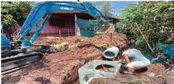
๓๖.โครงการวางท่อระบายน้ำ คสล.ชั้น ๓ หมู่ที่ ๒ (บ้านท่าสบก)
