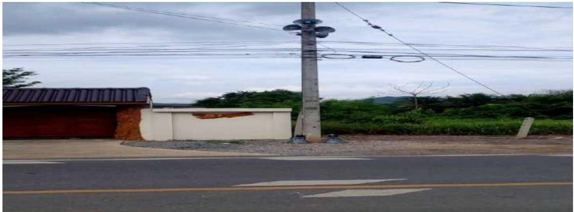
โครงการติดตั้งโคมไฟส่องสว่าง ม.๘
