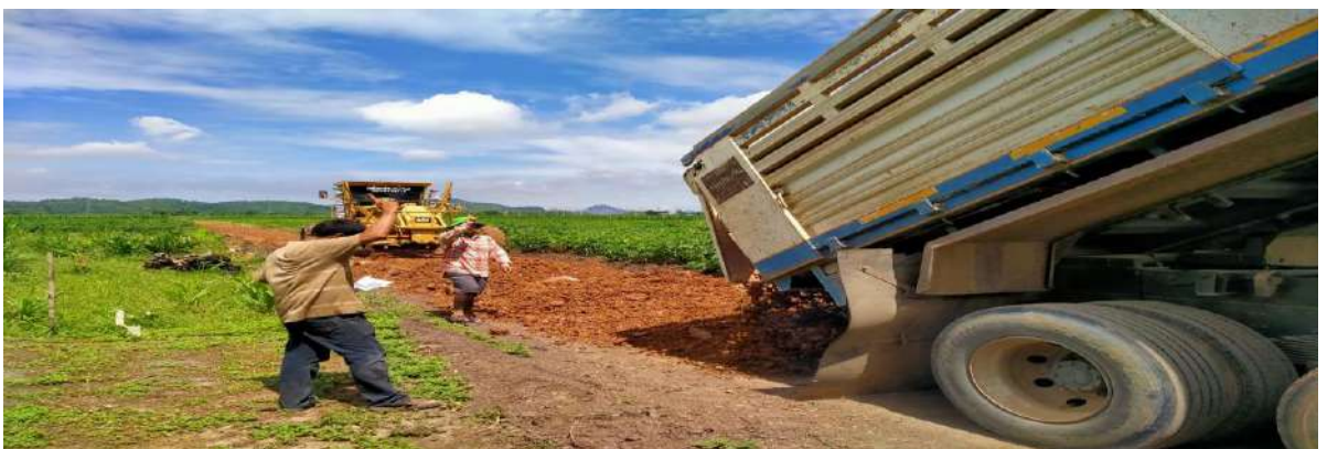
โครงการวางท่อระบายน้ำ คสล.ชั้น ๓ ม.๑๐
